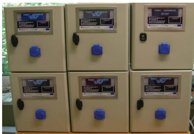
Rys. 3. Terminale garażowe w trakcie testowania
